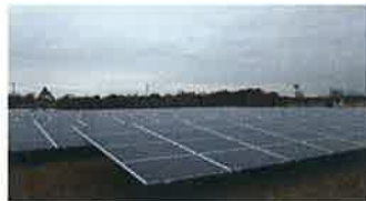
●メガソーラーシステム(工事中)
